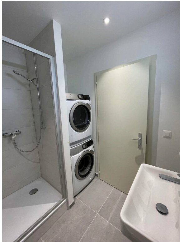
Colonne de lavage
